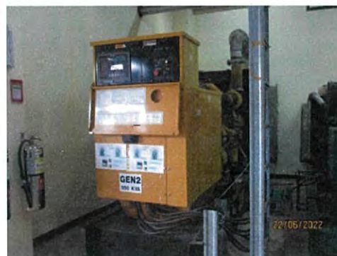
ภาพที่ 2-3 ปั๊มและเครื่องกำเนิดไฟฟ้าสำรอง
