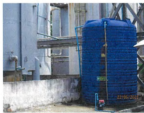
ภาพที่ 2-11 ถังพักน้ำทิ้งขนาด 10 ลูกบาศก์เมตร
