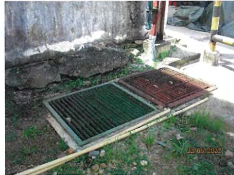
ภาพที่ 2-26 บ่อดักน้ำมันเพื่อรองรับน้ำและน้ำมันดีเซลรั่วไหล
