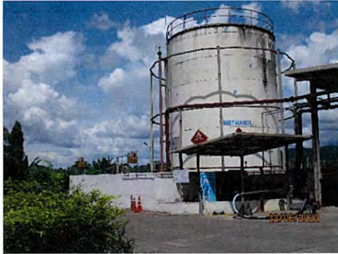
ภาพที่ 2-20 คันคอนกรีตกั้นน้ำบริเวณลานถังเก็บก๊าซสารเคมี
