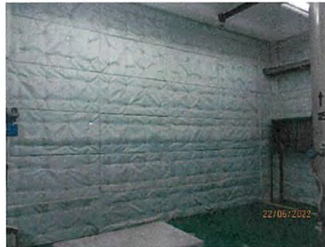
ภาพที่ 2-8 วัสดุดูดซับเสียงภายในอาคารเครื่องปรับอากาศ
