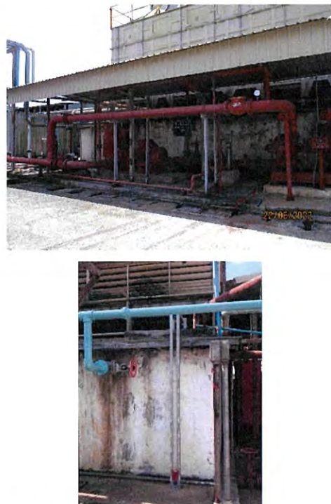
ภาพที่ 2-58 เครื่องสูบน้ำดับเพลิงและถังเก็บน้ำสำรองดับเพลิง
