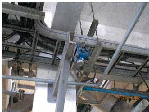
ภาพที่ 2-46 เครื่องตรวจวัดการรั่วของฟอร์มัลดีไฮด์แบบต่อเนื่อง (Gas Detector)
