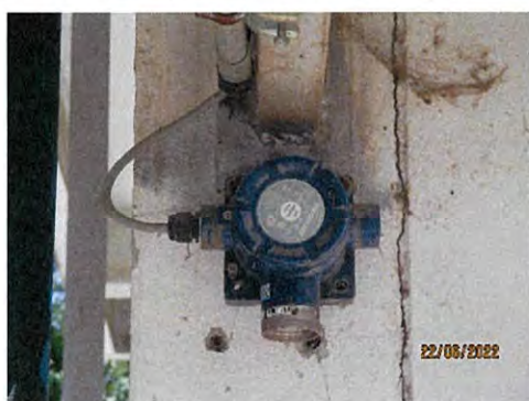
ภาพที่ 2-47 เครื่องตรวจวัดความเป็นพิษของสารเคมี (Toxic Gas Detector)
