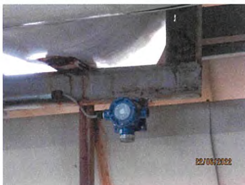
ภาพที่ 2-49 อุปกรณ์ตรวจจับเปลวไฟบริเวณท่อระหว่าง เครื่องระเหยกับถังปฏิกริยา
