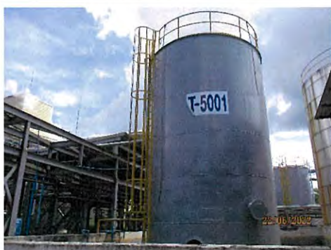
ภาพที่ 2-13 ถังพักน้ำเสียขนาด 120 ลูกบาศก์เมตร
