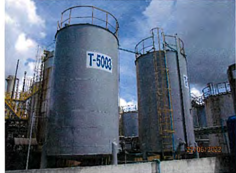
ภาพที่ 2-21 ถังพักน้ำเสียขนาด 90 ลูกบาศก์เมตร
