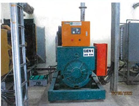
ภาพที่ 2-3 ปั๊มและเครื่องกำเนิดไฟฟ้าสำรอง
