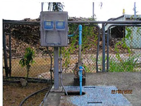
ภาพที่ 2-23 อุปกรณ์ตรวจวัดค่าความนำไฟฟ้า แบบอัตโนมัติ
