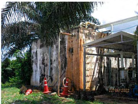
ภาพที่ 2-34 บ่อพักน้ำบาดาลขนาด 60 ลูกบาศก์เมตร
