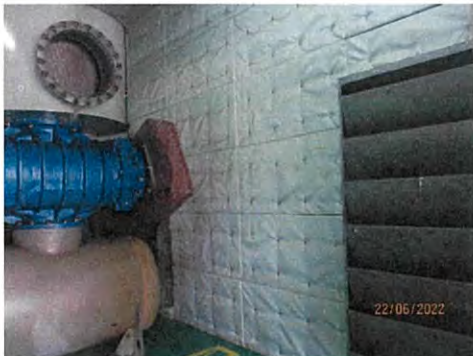
ภาพที่ 2-8 วัสดุดูดซับเสียงภายในอาคารเครื่องปรับอากาศ
