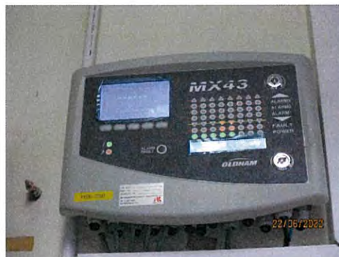
ภาพที่ 2-46 เครื่องตรวจวัดการรั่วของฟอร์มัลดีไฮด์แบบต่อเนื่อง (Gas Detector)
