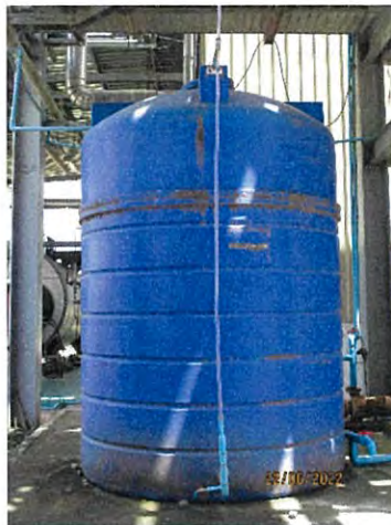
ภาพที่ 2-17 ถังพักน้ำทิ้งฉุกเฉินขนาด 10 ลูกบาศก์เมตร
