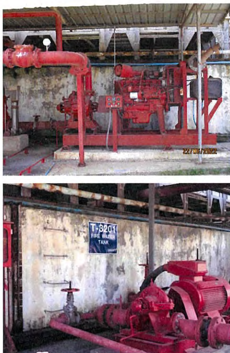
ภาพที่ 2-58 เครื่องสูบน้ำดับเพลิงและถังเก็บน้ำสำรองดับเพลิง
