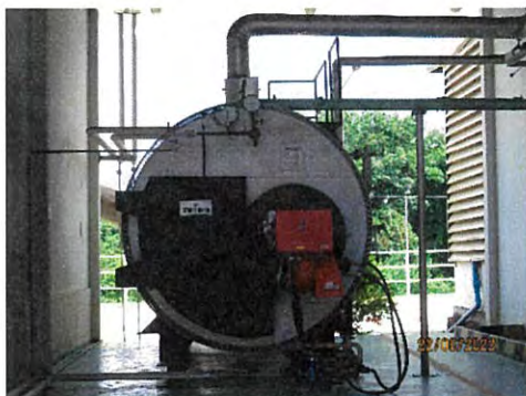
ภาพที่ 2-1 หม้อไอน้ำสำเร็จรูป
