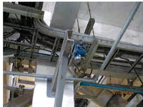
ภาพที่ 2-5 เครื่องตรวจวัดการรั่วของฟอร์มาลดีไฮด์แบบต่อเนื่อง (Gas Detector)
