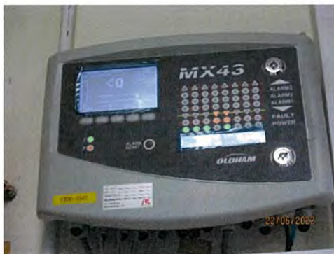
ภาพที่ 2-5 เครื่องตรวจวัดการรั่วของฟอร์มาลดีไฮด์แบบต่อเนื่อง (Gas Detector)
