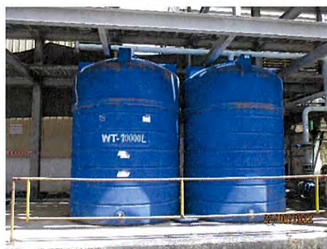
ภาพที่ 2-14 ถังพักน้ำทิ้ง 20 ลูกบาศก์เมตร
